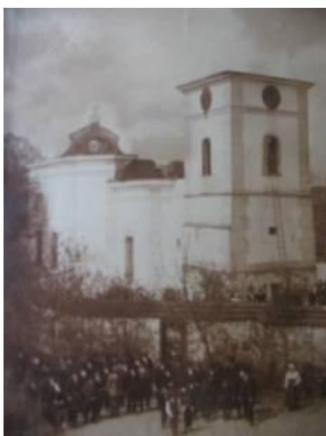
(obr. 6) - kostel po r.1907 - plechová střecha, chybějící boční kaple u presbytáře
